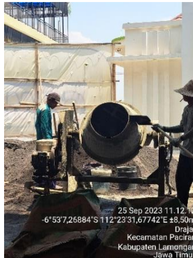
Gambar 6. Pembuatan Beton
