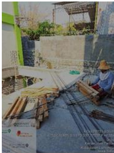
Gambar 4. Pembuatan Stang Pengaku
