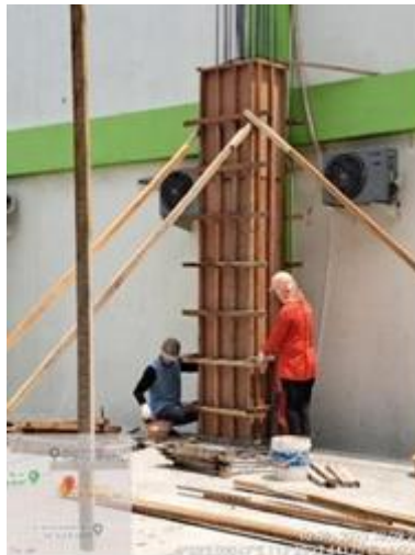
Gambar 5. Pemasangan Bekisting
