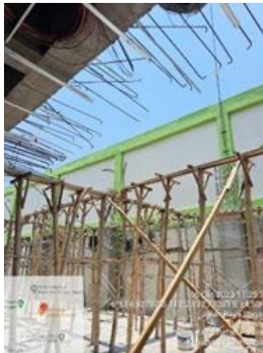
Gambar 7. Pembongkaran Bekisting
